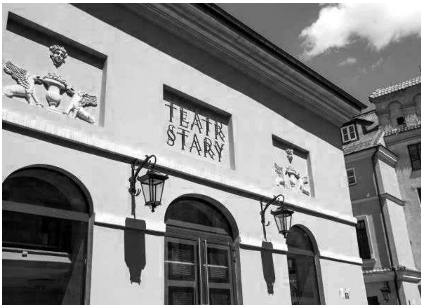
Teatr Stary w Lublinie, fasada po remoncie 2012, foto. archiwum
